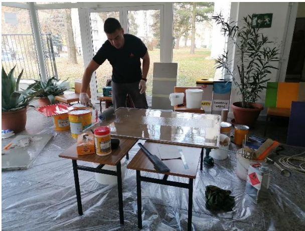
Názorné ukážky aplikácie polyuretánovej podlahy na vzorke
